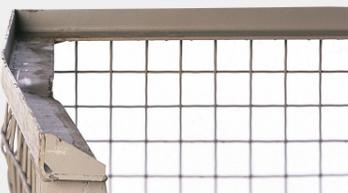
Der Steilwinkelaufsatz oder die Ecksäulen sind verformt.
